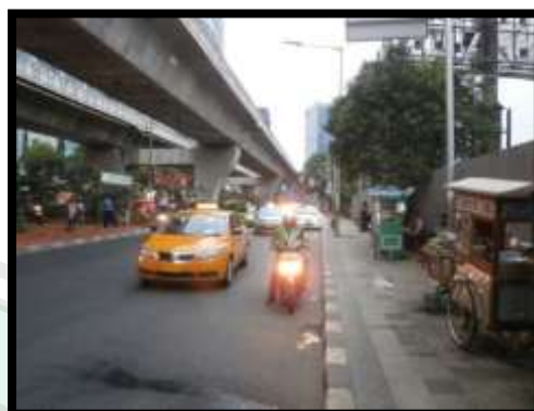
Gambar 4.7 Jalan depan tapak (Sumber : Dokumentasi Pribadi)
