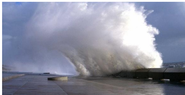
Gambar 1.7. overtopping yang terjadi pada breakwater (Sumber: www.clash-eu.org )
