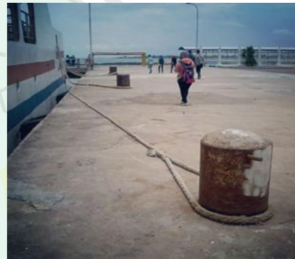
Gambar 2.23. Bolder pada pelabuhan (Sumber: instagramx.com )
