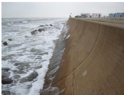
Gambar 2.20. Dinding Penahan pada pelabuhan (Sumber: blog.ucsusa.org )
