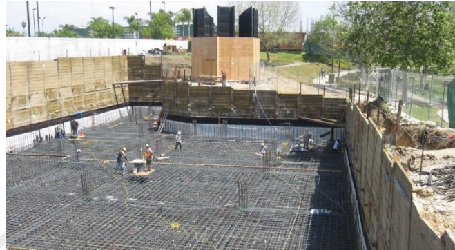
Gambar 5.20. Contoh Penerapan Pondasi Matras (Sumber: google.co.id)
