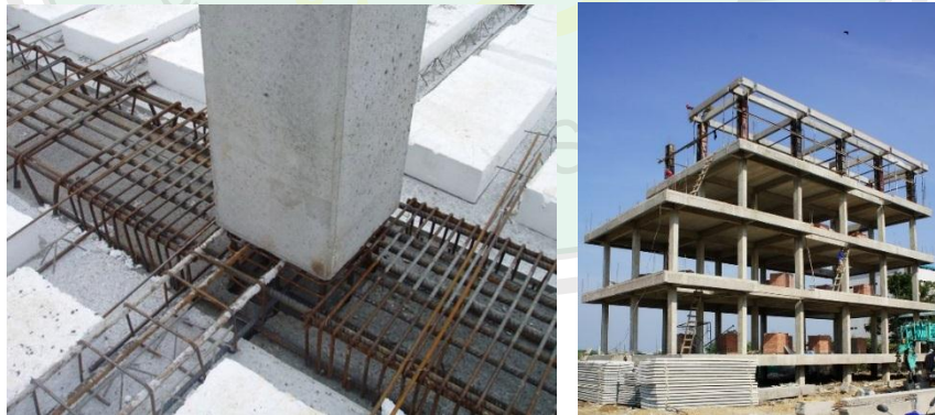
Gambar 5.21. Contoh kolom balok beton bertulang dan Penerapannya (Sumber: google.co.id)
