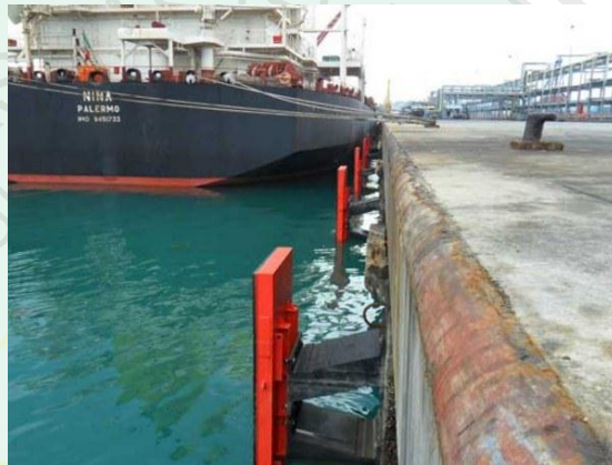
Gambar 2.21. Fender pada pelabuhan (Sumber: safembrik.blogspot.com )
