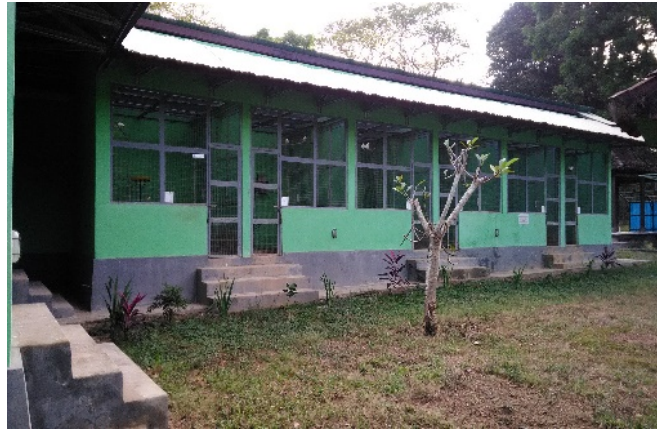
Gambar 4.2.2.1.1. Kandang Pemiakan bagian Barat (dokumen pribadi)
