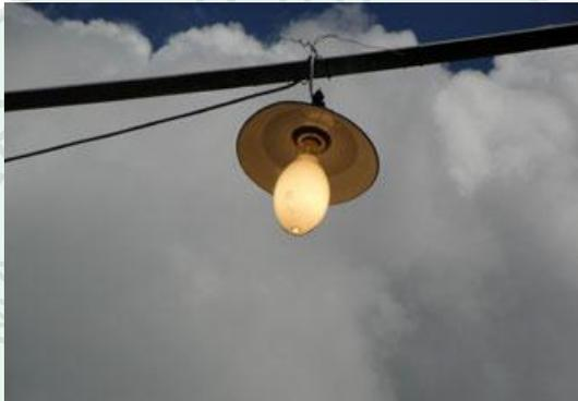
Gambar 2.50 Penerangan TPA Segawe yang menggunakan biogas
