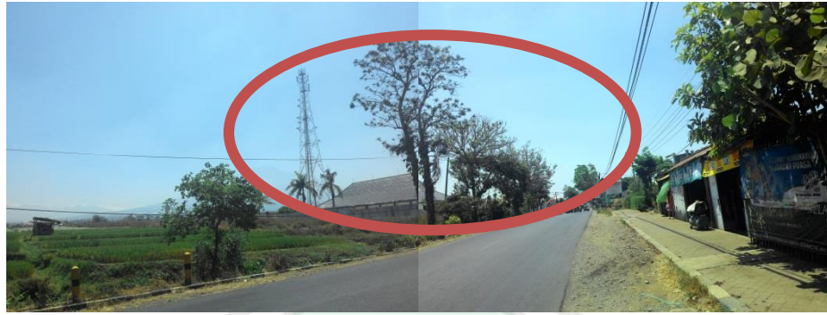
Gambar 4.9 Utilitas listrik di tapak (Sumber : Dokumentasi pribadi, 2015)
