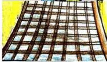
Terdapat rangka-rangka yang terletak pada fasad bangunan. Hal tersebut berfungsi sebagai shading yang diletakkan secara vertikal dan horisontal. Hal tersebut juga berfungsi sebagai penguat dari struktur yang membentang agar kelengkungan tetap stabil.
