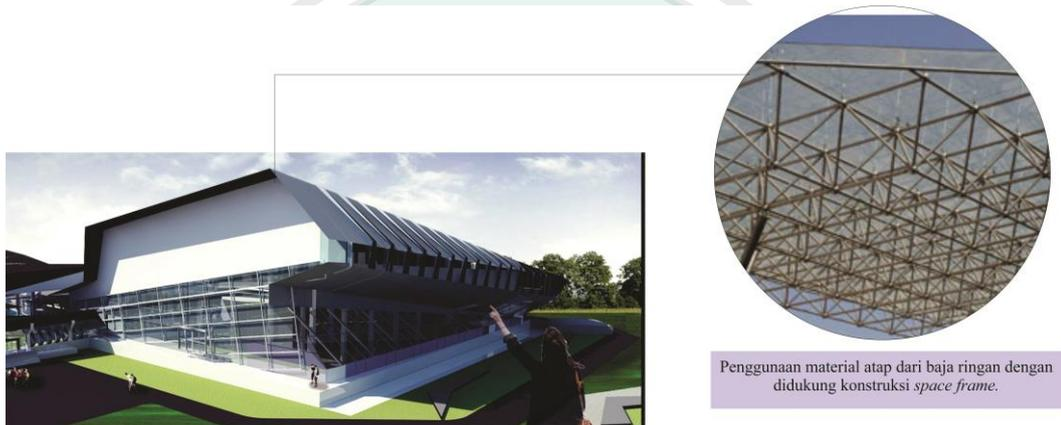
Penggunaan material atap dari baja ringan dengan didukung konstruksi *space frame*.
