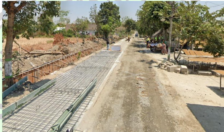
Gambar 2.5 Foto pembangunan Jalan Beton di Desa Cengkir Kecamatan Kepohbaru diambil pada tanggal 20 Oktober 2020
