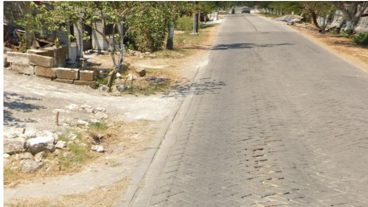
Gambar 2.4 Foto perbatasan Jalan paving dan Beton di Desa Sidomukti Kecamatan Kepohbaru diambil pada tanggal 25 Oktober 2020
