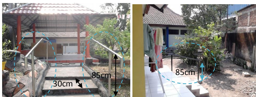
Gambar 2.7. Tersedianya Railing Tangga Sumber : Dokumentasi Pribadi
