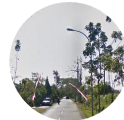
Terdapat lampu jalan sepanjang jalan Junrejo
