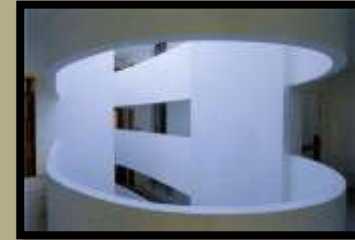
Terdapat void ditegah bangunan dan tangga mengitari void sehingga pencahayaan untuk tangga dan per unit sangat baik.
