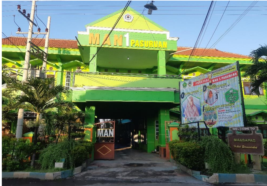
Madrasah Gedung Selatan
