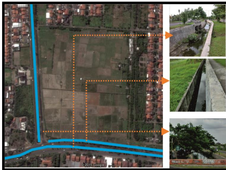
Gambar 4.13 : Saluran Drainase Sumber : Dokumentasi Pribadi,2015
