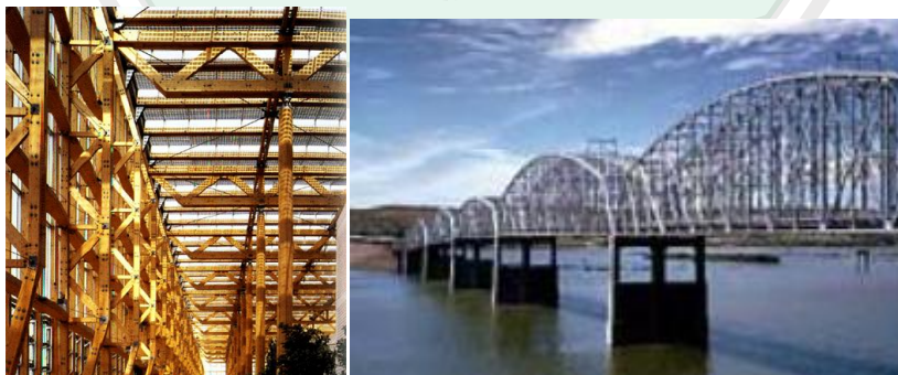
Gambar 2.25 Struktur Rangka Batang
