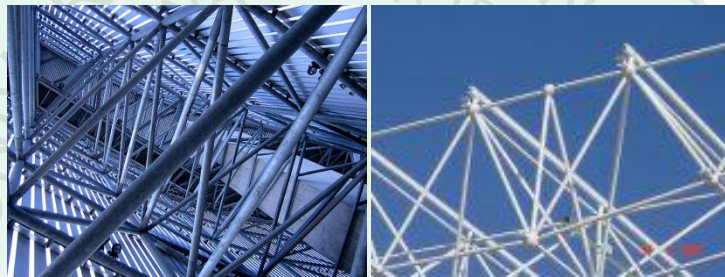
Gambar 2.26 Struktur Rangka Ruang
