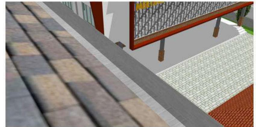
Sedangkan pada atap bangunan terdapat talang untuk mengalirkan saluran air hujan pada area resapan.
