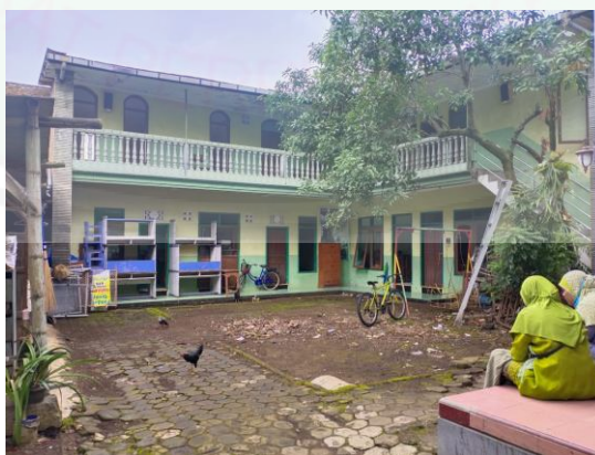
Bangunan Ruang Kelas TPQ Ar Rochman
