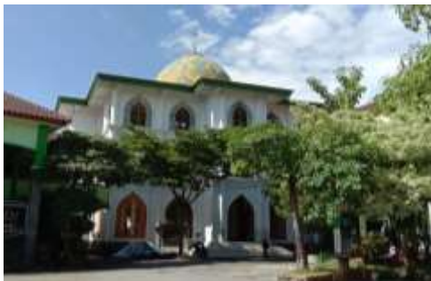
Gambar. 11 (Kondisi Masjid Al – Barokah MTs N 1 Lamongan)
