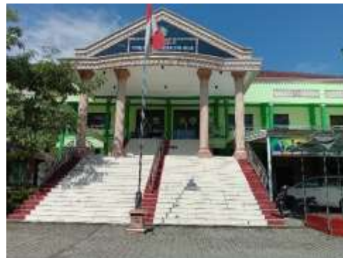
Gambar. 12 (Kondisi Aula MTs N 1 Lamongan)
