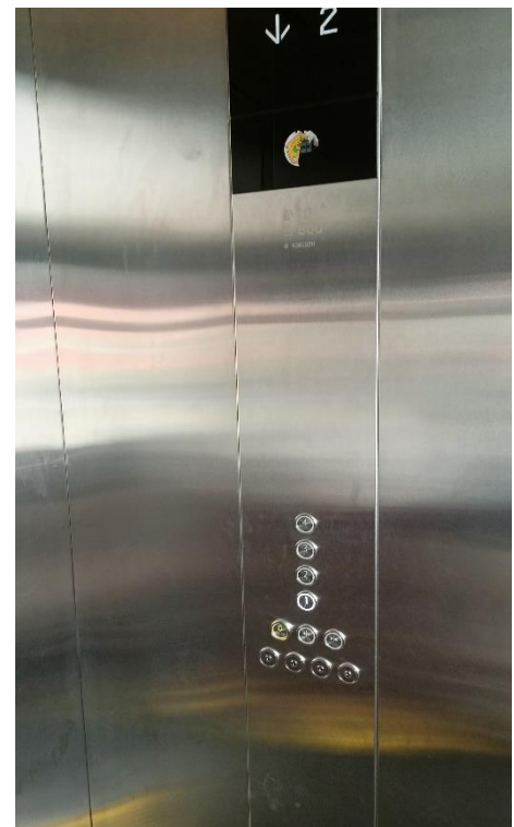
Fasilitas lift di sekolah
