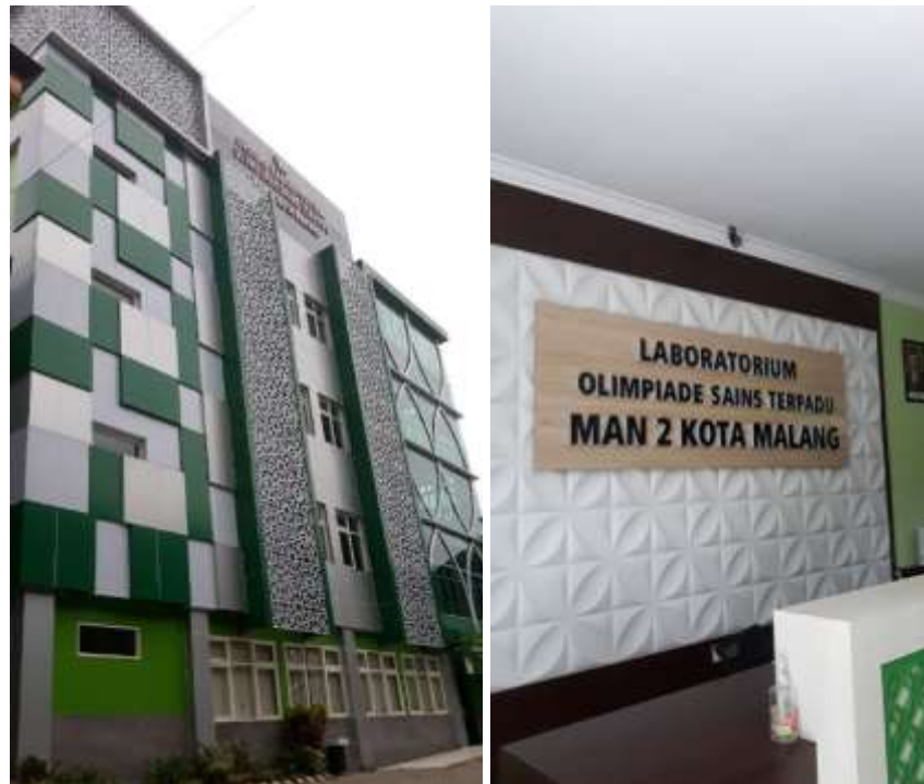
Gambar 4. 14 Gedung Olimpiade MAN 2 Kota Malang. 148
