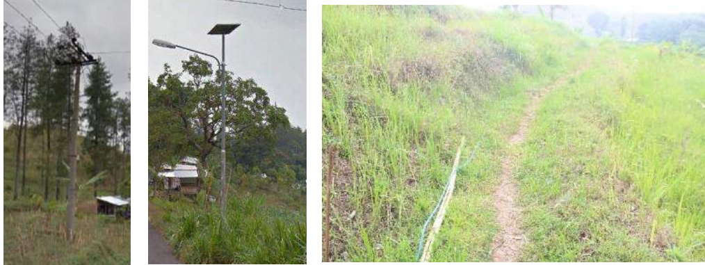
Gambar 4. 5 Tiang Listrik Dan Lampu Jalan Beserta Jalan Setapak
