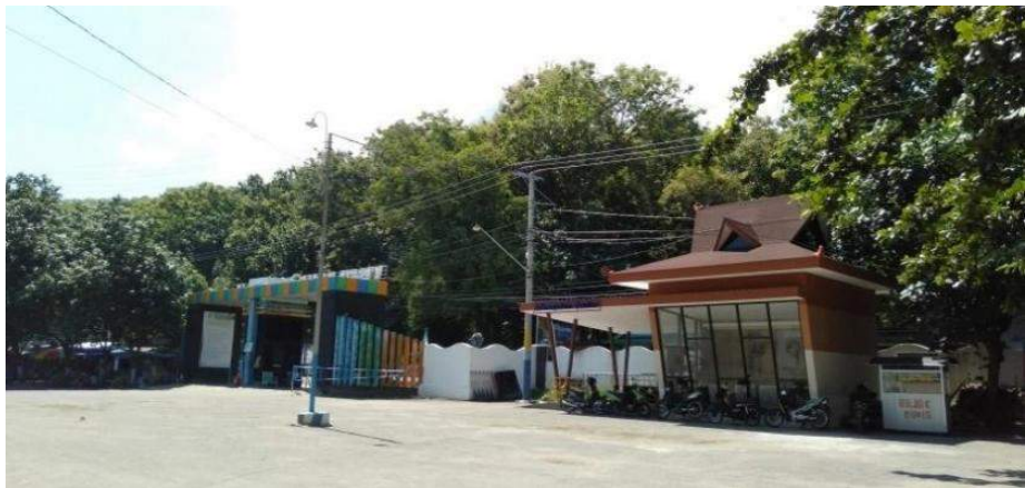
Gambar 4.14 Tiang listrik Dalam Tapak (Sumber: Dokumentasi pribadi, 2019)
