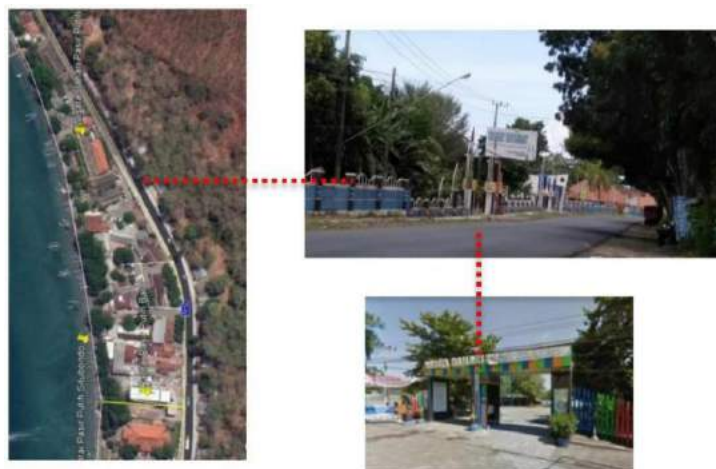
Gambar 4.11 Sirkulasi dan Aksesibilitas (Sumber: Dokumentasi Pribadi,2019)
