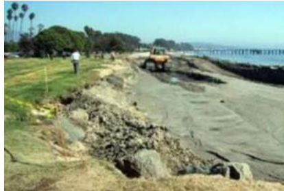
Gambar 2.13 Pengisian Pasir ( Sand Nourishment ) (Sumber: Modul 05 Pengenalan Bangunan Pantai)
