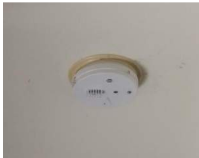
Gambar 2.44 Detector Panas (Sumber: Internet)
