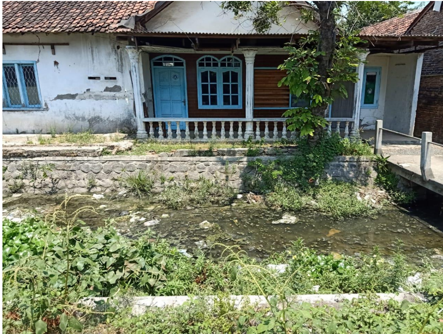
Gambar 10. Salah satu rumah yang mengalami keretakan
