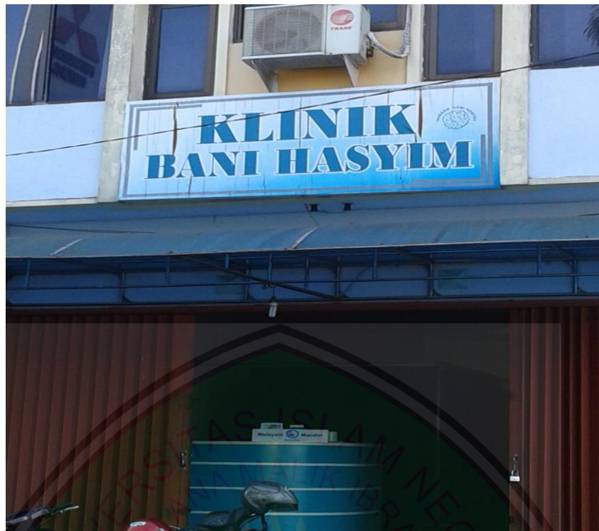
Gambar. 16. Fasilitas Klinik Bani Hasyim, dokumentasi tanggal 17 September 2014
