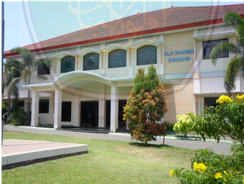
Gambar. 4. Gedung KB-TK Bani Hasyim, dokumentasi tanggal 26 September 2014
