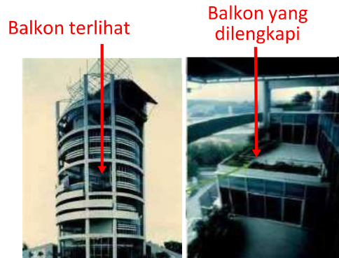
Gambar 2.49. Balkon Menara Mesiniaga
