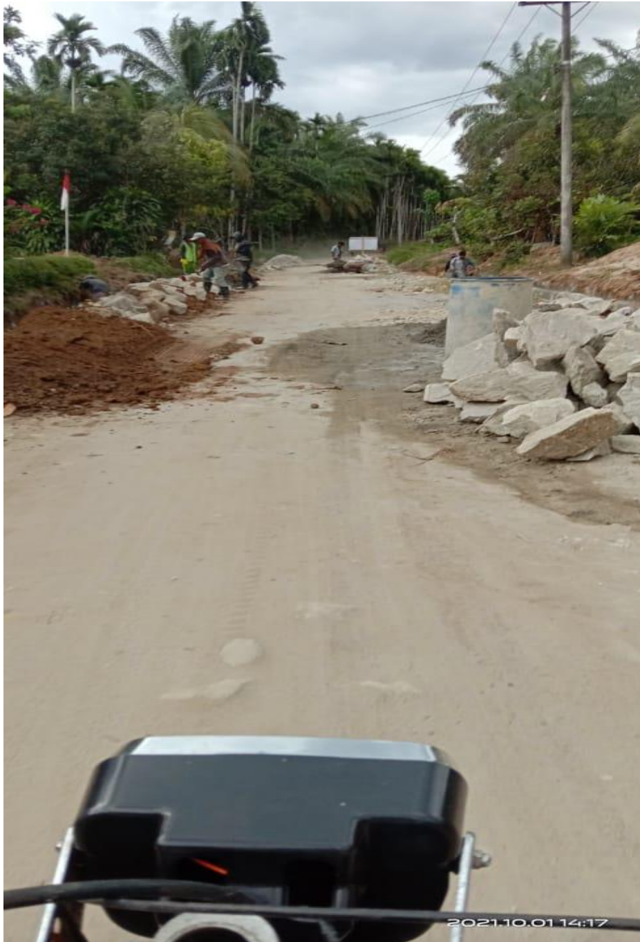
(Dokumentasi Pembuatan Gorong Gorong Di Desa Gonting Malaha)
