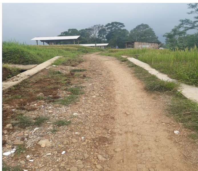
Akses jalan yang baru diperbaiki
