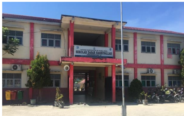
Gambar 4.8 Gedung Utama SD Hasbunallah
