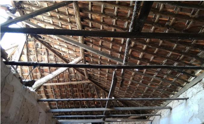
**Gambar 4.17 Mangrove yang Digunakan untuk Membuat Kerangka Atap Rumah Sumber : (Dokumentasi Pribadi, 2020)**
