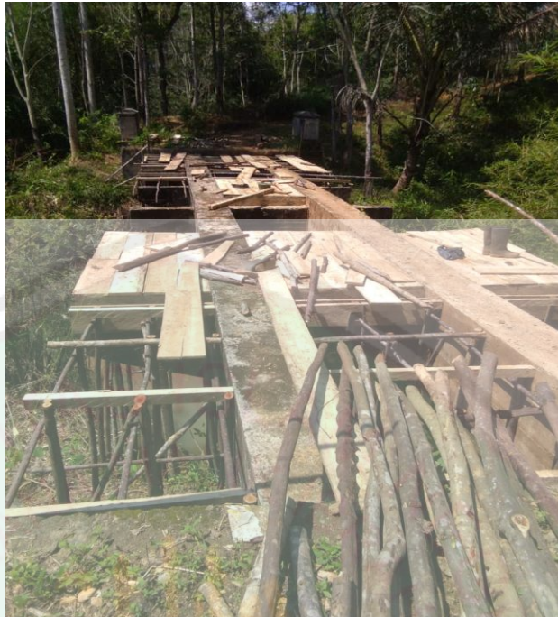
Lokasi pembangunan Infrastruktur jembatan.
