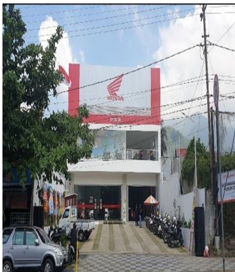
Bangunan yang tidak memiliki IMB di Jl. Raya Panglima Sudirman Kecamatan Batu Kota Batu
