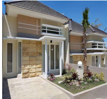
Bangunan yang tidak memiliki IMB di Jl.Mojoagung Rt 8 Rw 4 Desa Mojorejo Kec Junrejo Kota Batu
