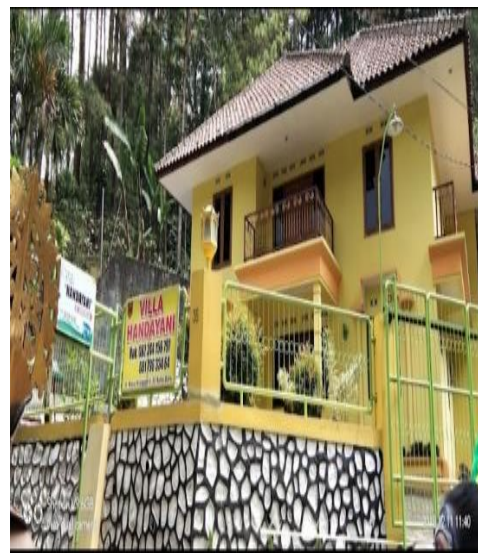
Bangunan yang tidak memiliki IMB di Jl. Raya Selecta Tulungrejo Kec. Bumiaji Kota Batu
