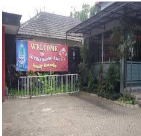
Bangunan yang tidak memiliki IMB di Jl.Raya Telekung No.101 Tlekung Kec.Junrejo Kota Batu
