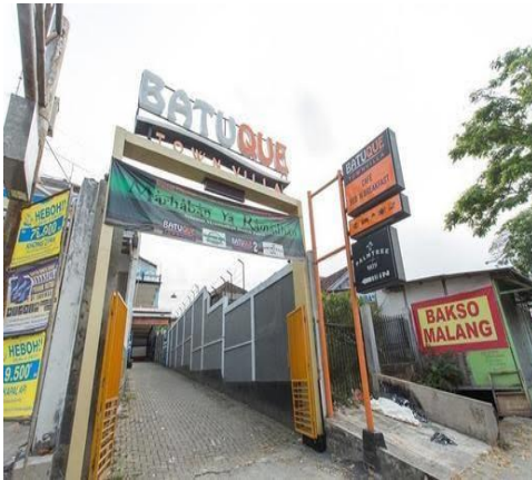
Bangunan yang tidak memiliki IMB di Jl.Oro-Oro Ombo 235 Kec.Batu Kota Batu
