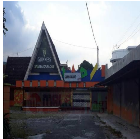
Bangunan yang tidak memiliki IMB di Jl.Panglima Sudirman No.106 Pesanggrahan Kec. Batu Kota Batu
