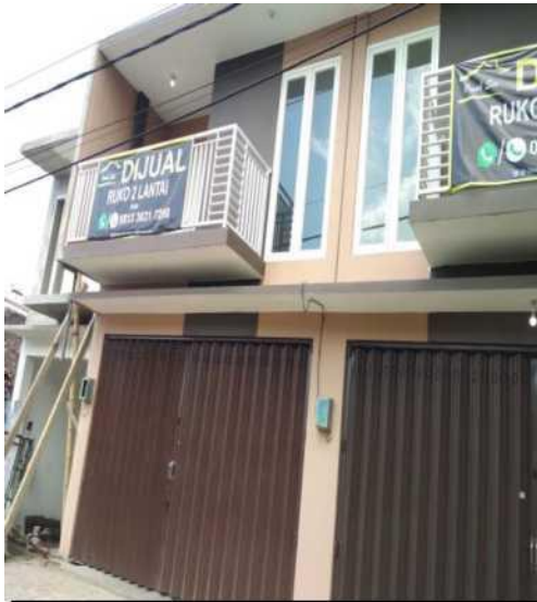
Bangunan yang tidak memiliki IMB di Jl. Abdul Gani atas No. 25 ngalik Kec. Batu, Kota Batu
