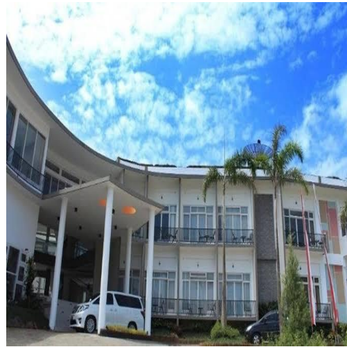
Bangunan yang tidak memiliki IMB di Jl. Abdul Gani Atas No.1 Ngaglik Kec.Batu Kota Batu
