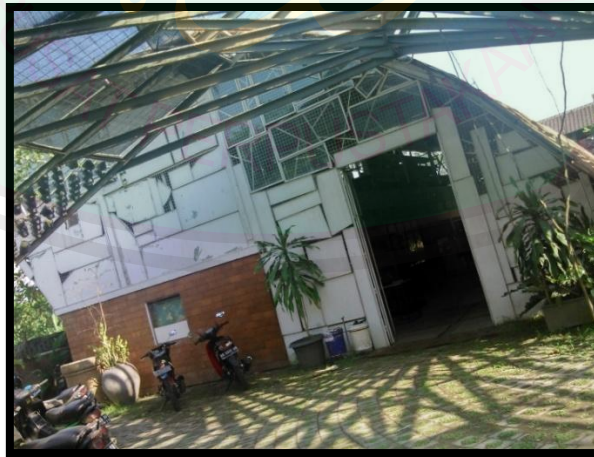
Gambar 2.45 Kaca Bekas Sebagai Pengisi Dinding (Sumber: Dokumentasi Penulis, 2014)
