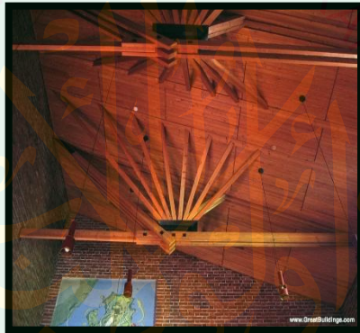
Gambar 2.55 Penggunaan Material Kayu Dari Lokasi Sekitar Dalam Struktur Atap (Sumber: www.greatbuildings.com/Saynatsalo_Town_Hall.html )
