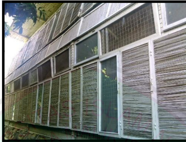
Gambar 2.44 Jendela Bekas Kontruksi Sebagai Ornamen Dinding Luar (Sumber: Dokumentasi Penulis, 2014)
