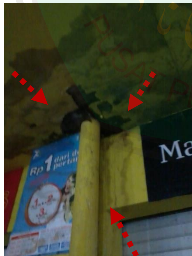
Gambar 2.48. kerusakan struktur utama terlihat pada sambungan kolom dan balok. (Sumber : dokumentasi pribadi)
