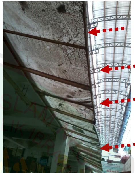
Gambar 2.47. pedagang menambah tritisan untuk mencegah masuknya air kedalam kios mereka. (Sumber : dokumentasi pribadi)
