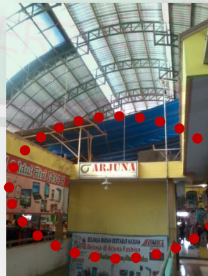
Gambar 1.2a. kondisi atap ditambal terpal.
