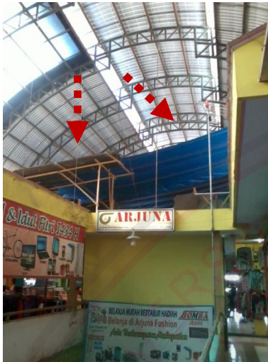
Gambar 2.46. tambahan terpal untuk melindungi kios dari debu dan air hujan akibat atap yang rusak (Sumber : dokumentasi pribadi)
