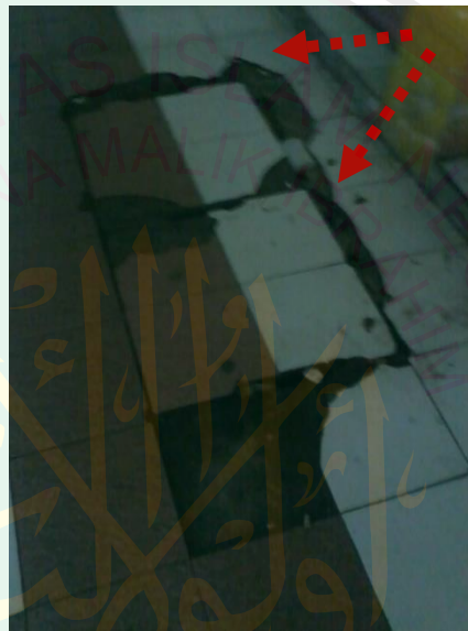
Gambar 2.45. Kerusakan keramik pada lantai bangunan.
