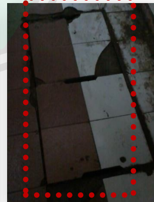
Gambar 1.2a. Keramik pecah - pecah
