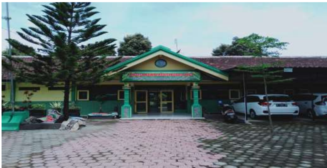
Dokumentasi dari bangunan SMPN 1 Semen Kabupaten Kediri tampak depan sebagai area masuk ke dalam sekolah
