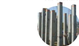
Pondasi pancang digunakan untuk mengikat bangunan ke dalam bumi agar meminimalisir kerusakan akibat bencana maupun settlement. Dilatasi struktur diterapkan pada setiap blok untukantisipasi bangunan collapse.
