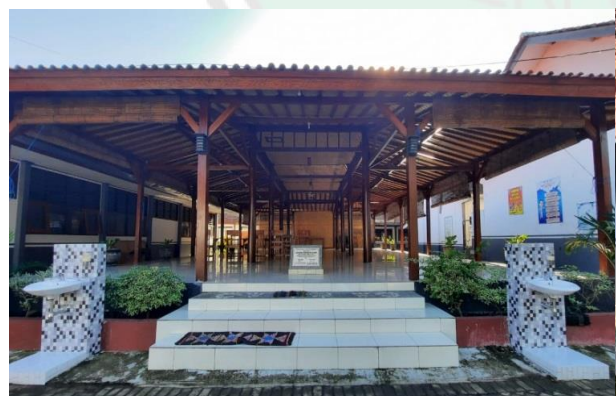
Gazebo atau Ruang Serbaguna
