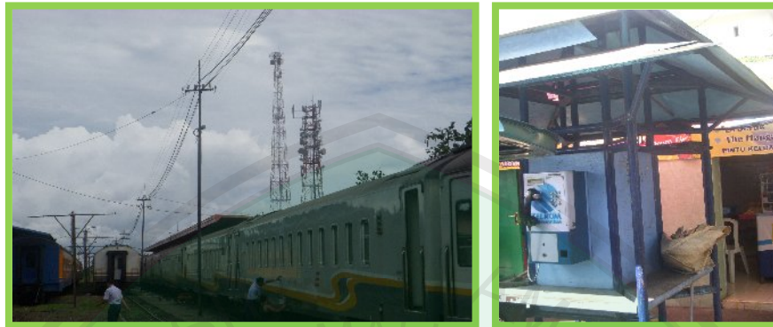
Gbr 4.4. Tower provider dan telepon umum Sumber: Dokumentasi pribadi (2010)
