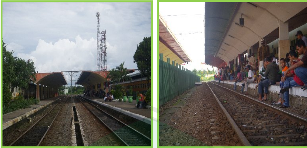
Gbr 4.71. Perlintasan kereta api Sumber: Dokumentasi pribadi (2010)
