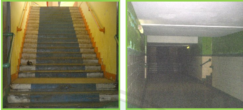
Gbr 4.70. Lorong bawah tanah Sumber: Dokumentasi pribadi(2010)
