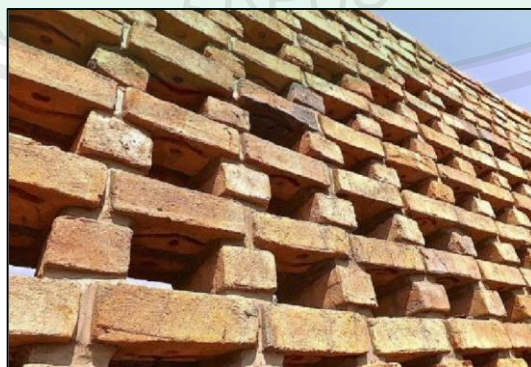
Gambar 2.35 Dinding Berlubang Batu Bata
