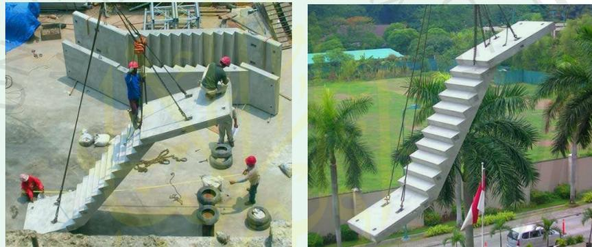
Gambar 4.48 Analisa Sistem Pemasangan Tangga
