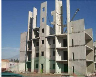
Gambar 4.44 Analisa Sistem Perakitan Struktur Dinding
