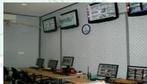
Gambar 2.41 Kantor Pengelola dan Ruang CCTV (Sumber: Google.com, 2013)
