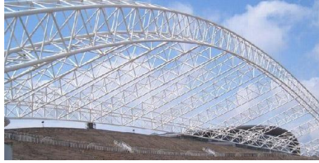
Gambar 2.9 Struktur Lengkung Space Frame (Sumber: Google.com, 2013)
