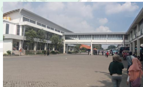
Gambar 2.36 Jembatan Penyebrangan (Sumber: Hasil Survei, 2013)
