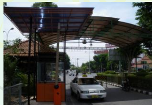
Gambar 2.49 Pintu Masuk Elektrik Kendaraan (Sumber: Hasil Survei, 2013)
