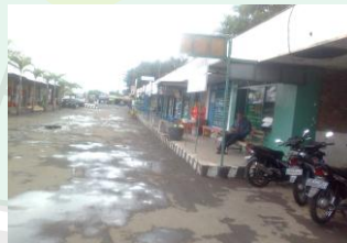
Kondisi bangunan pendukung terminal yang kurang terawat
