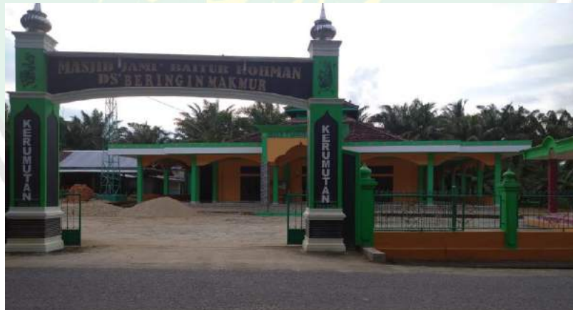
Dokumentasi 6. Bangunan Masjid Jami' Beringin Makmur
