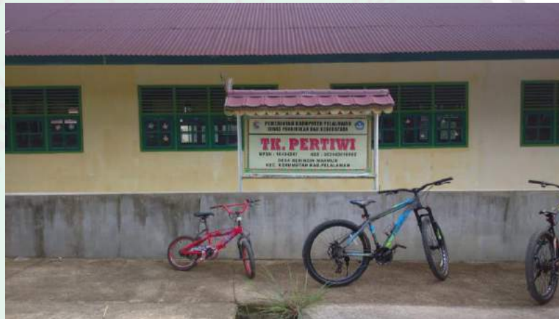
Dokumentasi 5. Bangunan TK Pertiwi Beringin Makmur
