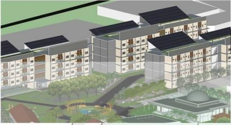
**Ruang Transisi**, penerapan prinsip ruang transisi pada perancangan Rusunawa yang diterapkan yaitu memberikan balkon pada setiap unit dan memberikan hubungan secara langsung pada void yang ada ditengah bangunan sehingga dapat memberikan kesan menyatu dengan alam.
