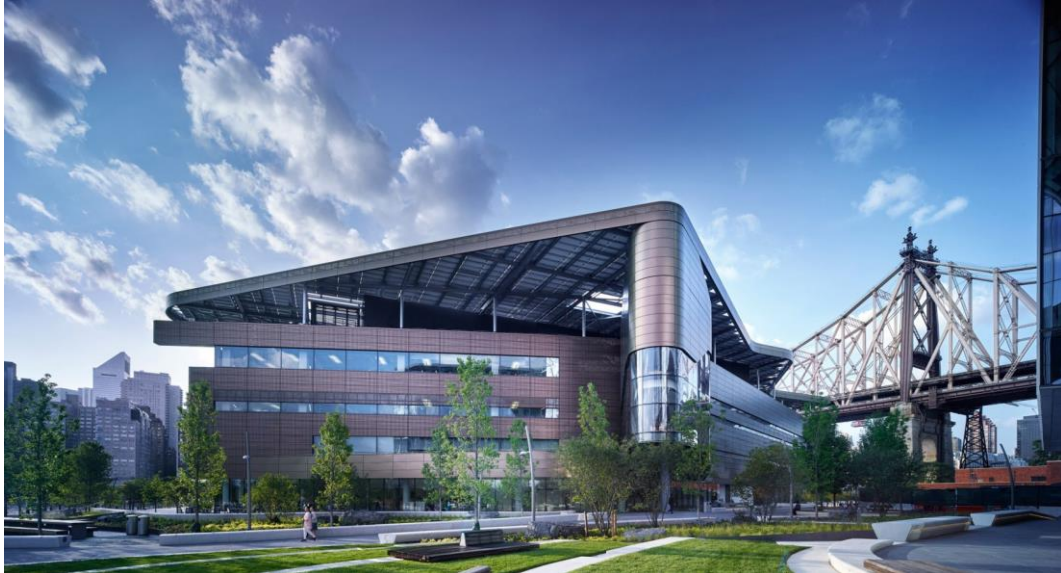
Gambar 2.17 Penggunaan Teknologi fasad Bangunan Cornell Tech Campus (Sumber: https://www.dezeen.com/2017/09/25/cornell-tech-campus )
