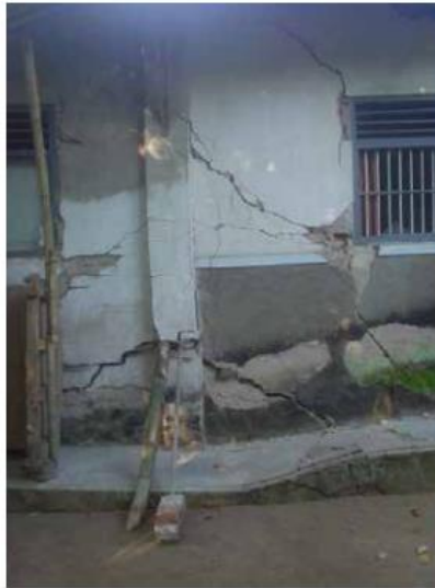
Gambar 4.17 Kerusakan rumah penduduk akibat proses likuifaksi di Bayat, Klaten, Jawa Tengah (Supartoyo dalam 2016)
