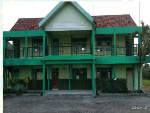
Tampak depan MTs Assa'adah
