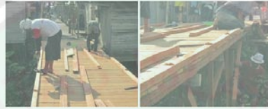
Gambar 2.56: pembuatan jembatan titian (Sumber; )
