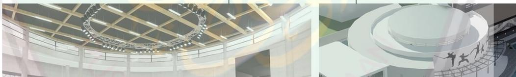
Struktur dengan sistem space frame digunakan pada competition hall untuk menopang bentangan yang paling lebar pada bangunan.
