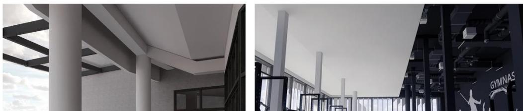
Kolom Struktur bentangan > 6 m pada bentukan balok yang melingkar (Area kompetisi) menggunakan beton bertulang yang fleksibel dan memiliki ketebalan yang mampu menopang struktur secara keseluruhan yaitu 60 cm
