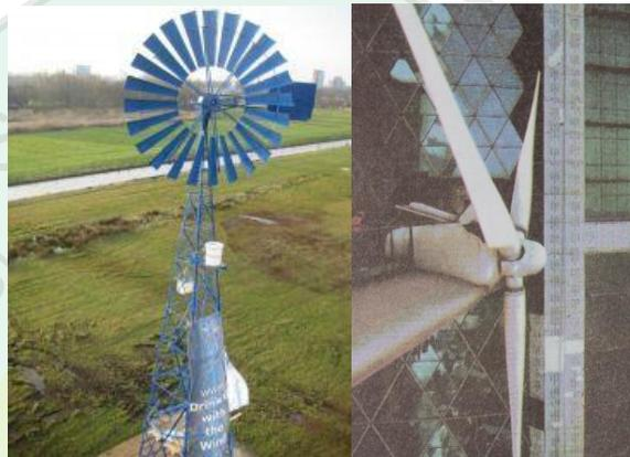
Gambar 2.45. Kincir angin sederhana dan baling-baling yang langsung menempel pada bangunan (Sumber: Google image. 2014)
