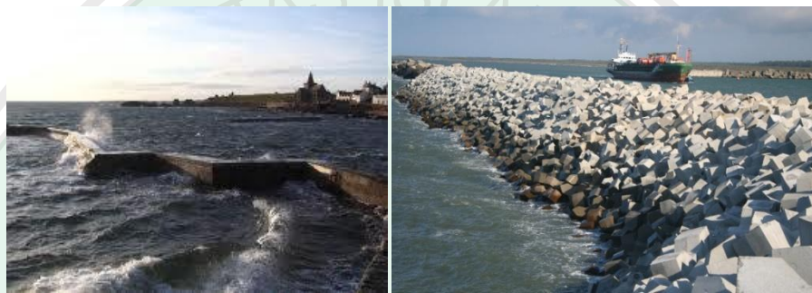
Gambar 2. 3 Breakwater pemecah gelombang laut (Sumber: sanggapramana.wordpress.com)
