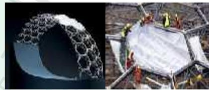
Rangka atap membentuk serat sayap lebah menggunakan sistem rangka MERO dan membran termo plastik
